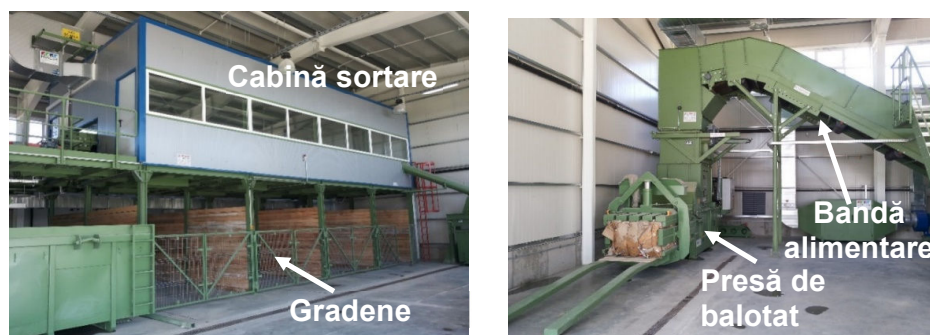
Figura 4.9. Imagini din Stația de sortare lanca
